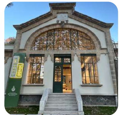
Cendere Sanat Ancienne station de pompage d'eau → désormais un espace d'art contemporain
