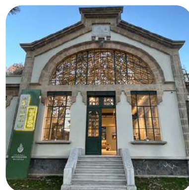
Изкуство Центере Бивша помпена станция → сега пространство за съвременно изкуство
