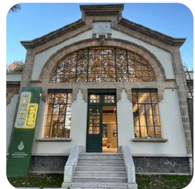
Τέχνη Σεντερέ Πρώην αντλιοστάσιο νερού → τώρα χώρος σύγχρονης τέχνης
